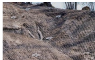
■TECCO (テコ) ネット 表層崩壊の恐れがある斜面に使用。
