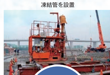
凍結管・測温管の設置 計測管理設備の設営
