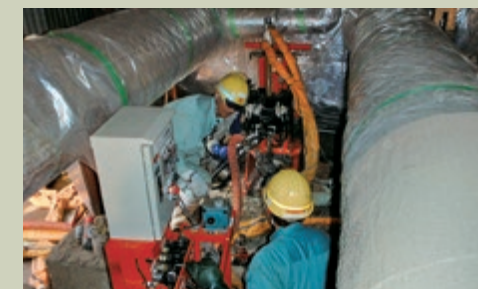
施設の配管の間から施工
