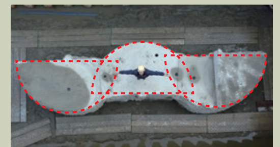
扇形の改良体を利用した壁状改良の例
