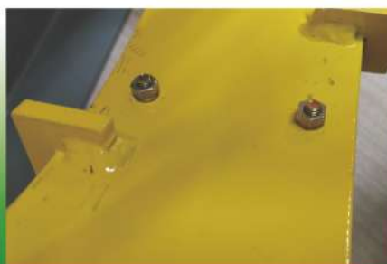
鉄板を本体に巻きつけ外側からボルトを通し、内側でナット止め 鉄板の外周にテープ付きスポンジを貼って交換完了
