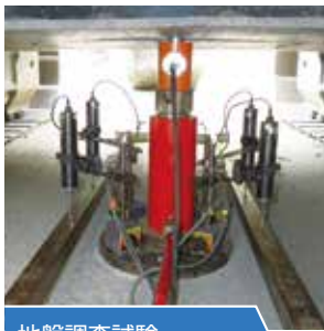
地盤調査試験
