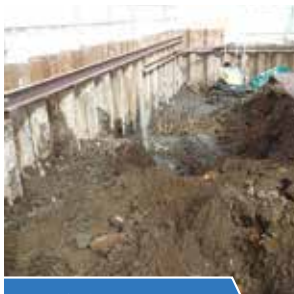
土壌浄化工事
