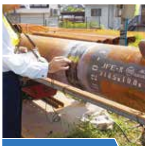
鋼構造物の非破壊検査
