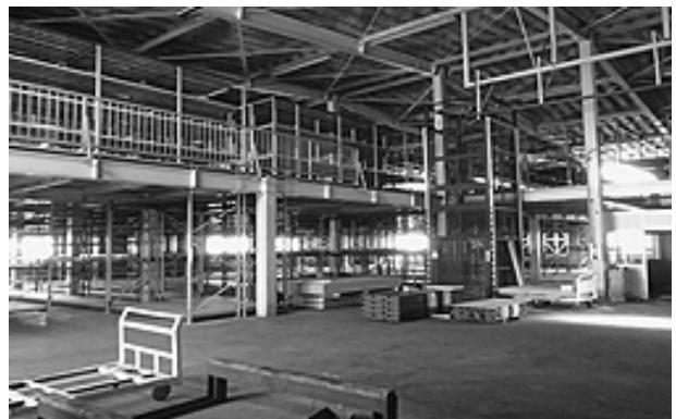
新倉庫内もジャロックのメザニンラックとエレベーターを設置している
