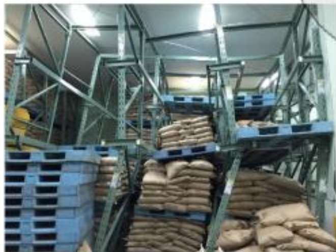
熊本地震（菊池郡） ドライブインラック水平ビーム無しによる事故
