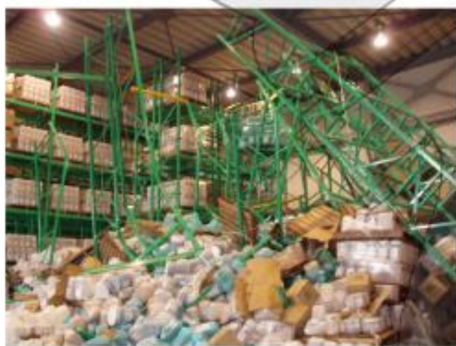
熊本地震（菊池郡） ドライブインラック水平ビーム無しによる事故
