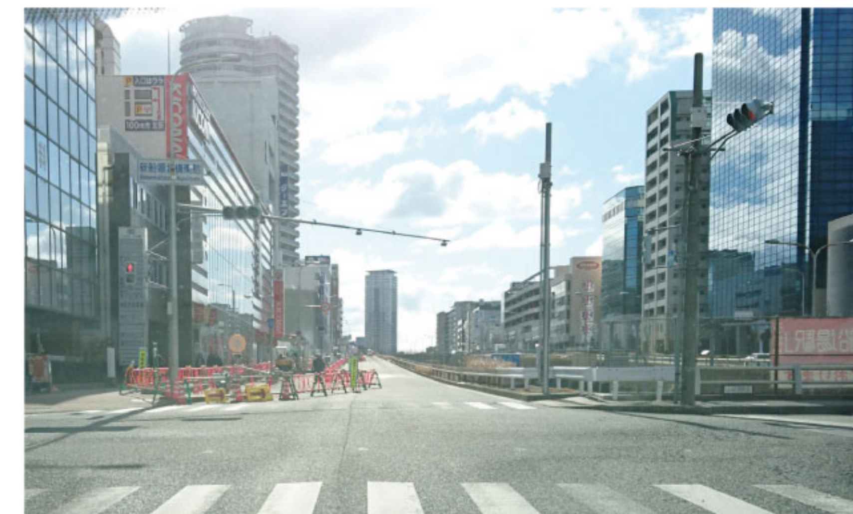
① 2016年12月28日 新船場北橋東詰から南方向に新御堂筋線東側側道を見る。 北大阪急行線延伸工事の為、車線規制が始まる。
