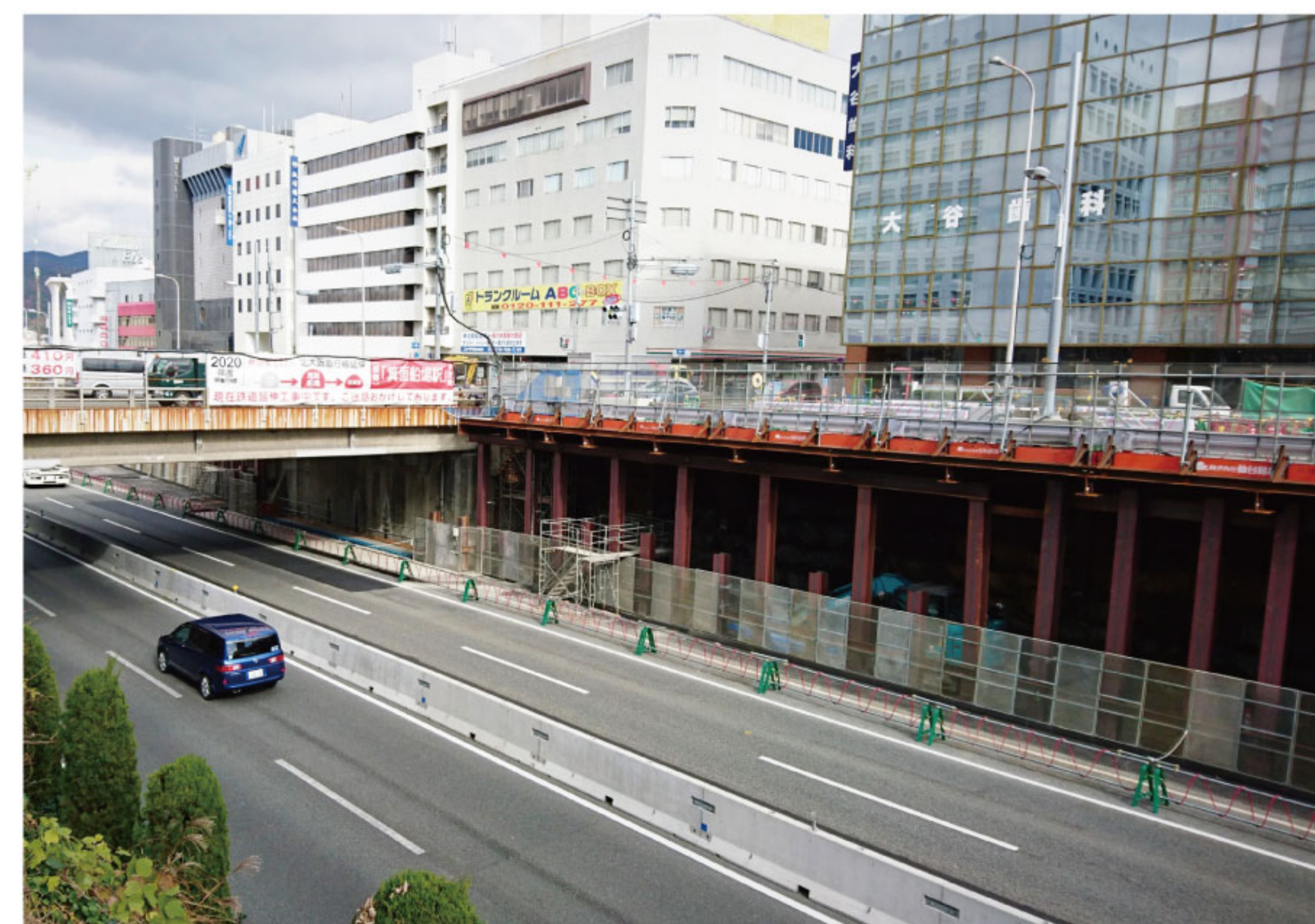
⑧ 2017年12月15日 新船場北橋東詰方面を臨む。仮設道路工事が見える。
