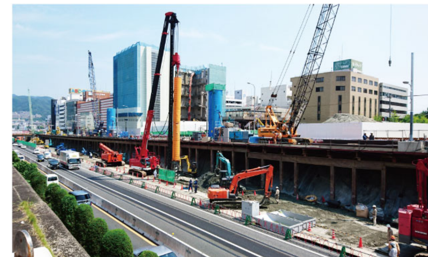
③ 2017年6月23日 新御堂筋線東側側道の仮設道路工事が進む。 と同時に建物解体工事が進められている。
