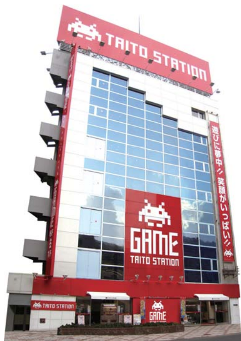
「タイトーステーション」のブランド認定を受けた優秀店。内部だけでなく、外部の厳しい審査をクリアした店舗のみが新しい看板とユニフォームを導入できるというもので、従業員のモチベーションのアップにもつながっている。初年度は82店が認定を受けた。
